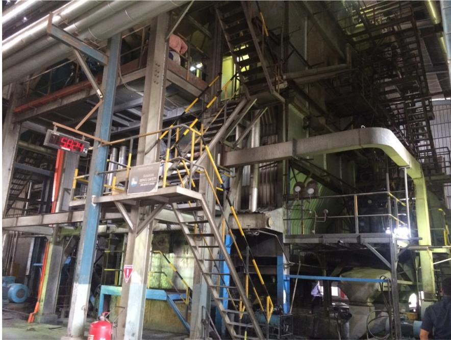
Gambar 3.2 Boiler Berkapasitas 40 Ton
