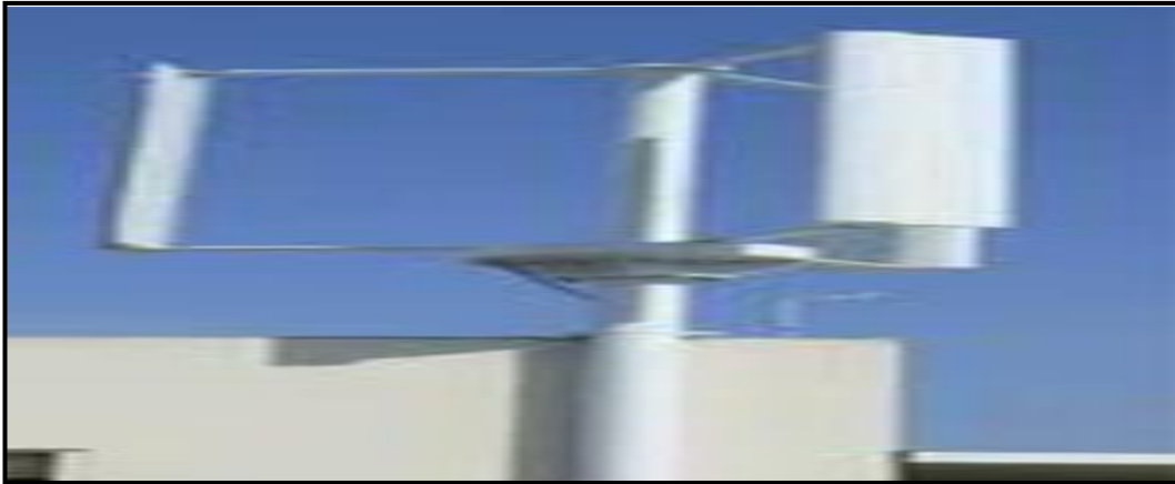
Gambar 2.7 Turbin Angin Sumbu Vertikal Tiper Giromil
