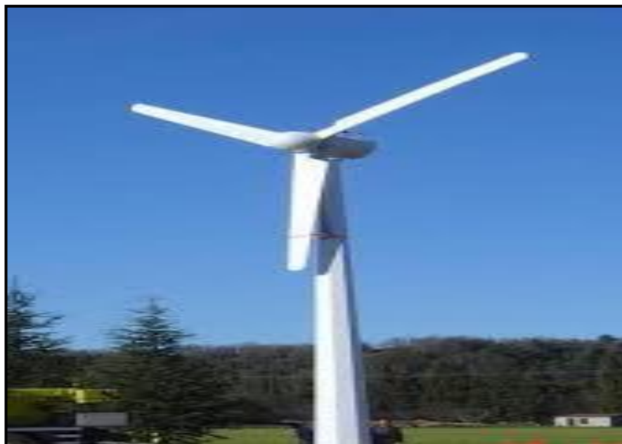
Gambar 2.5 Bentuk Turbin Angin Sumbu Horizontal (TASH)
