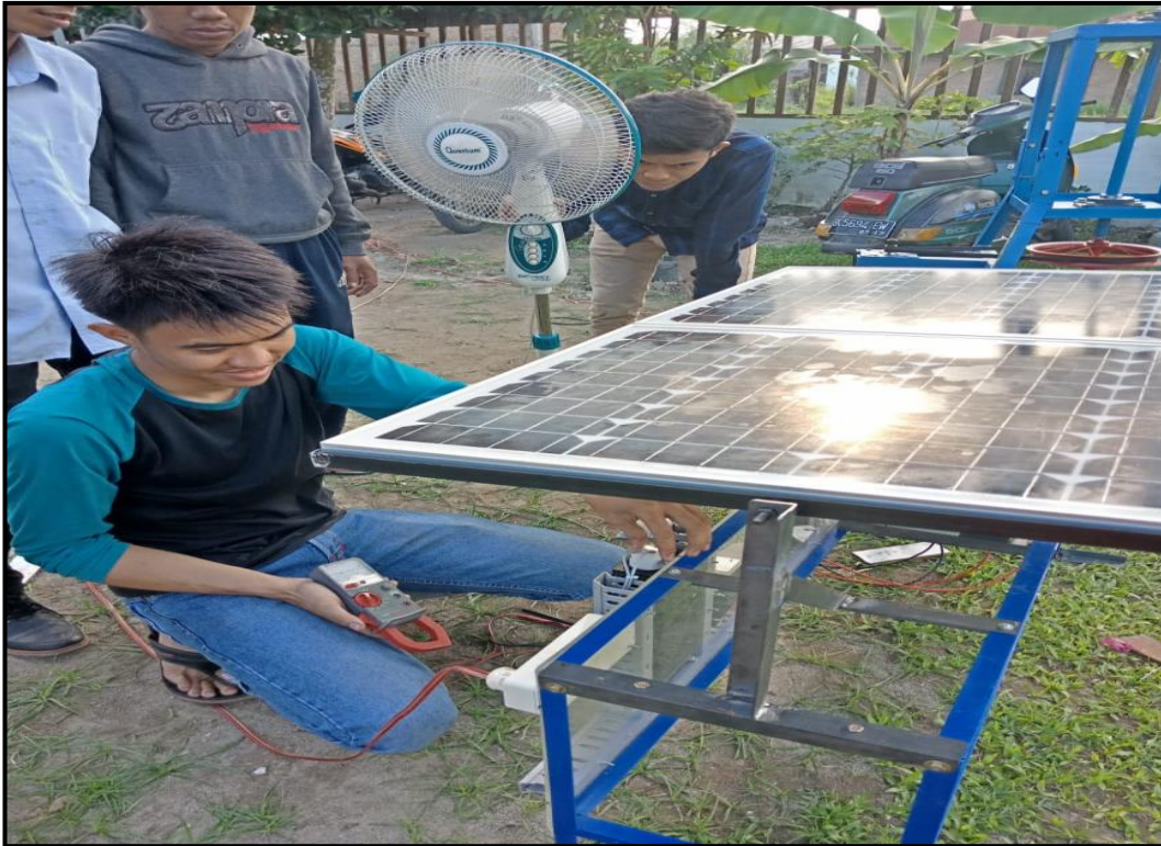
Gambar 1 Pengukuran Dan Pengujian Sistem Pada PLTS
