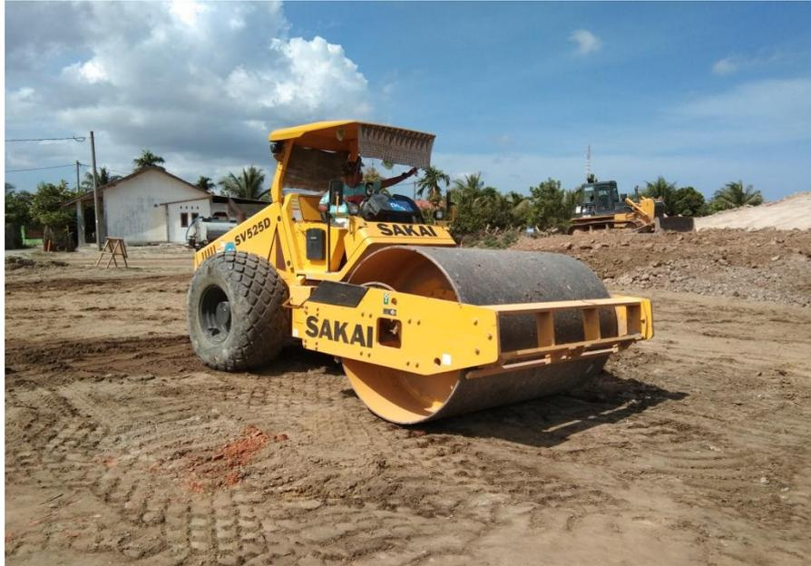
Gambar L5: Alat berat *vibrator roller* memadatkan tanah
