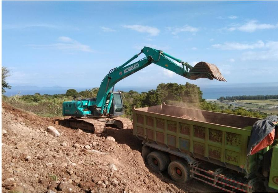
Gambar L3: *Excavator* memuat tanah timbunan
