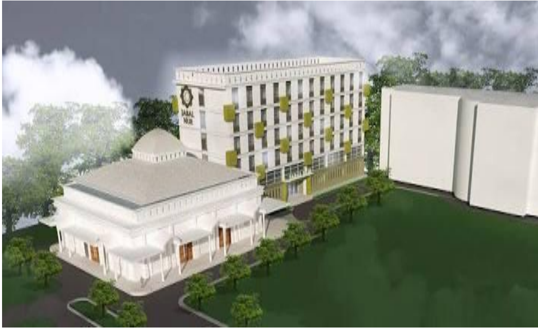
Gambar 3.3 : Proyek Pembangunan Gedung Jabal Nur
