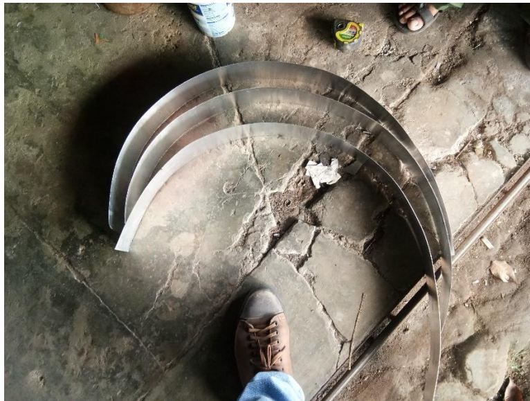
Gambar. 4.13. Potongan yang sudah dilengkungkan
