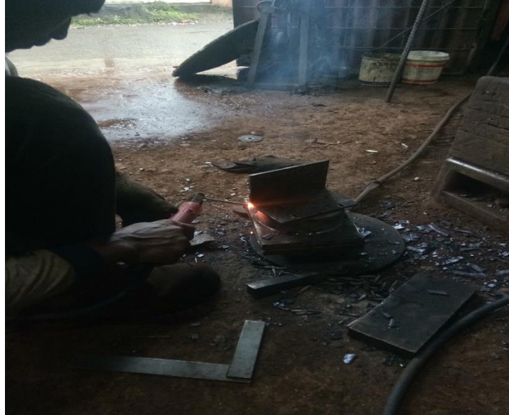
Gambar. 4.6. Pengelasan pada plat dudukan generator
