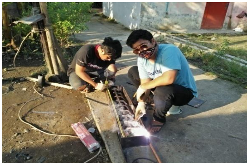
Gambar 4.13. Membuat Rangka ( body ) Alat Dengan Proses Pengelasan
