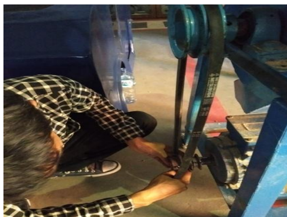
Gambar 3.14 pemasangan V belt
