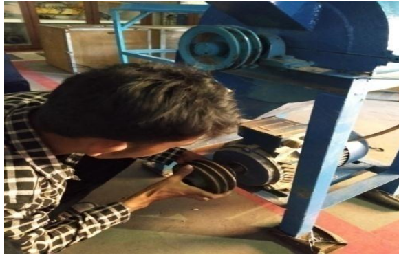
Gambar 3.21 pemasangan Pully Diameter 140
