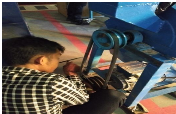
Gambar 3.22 Pemasangan V belt
