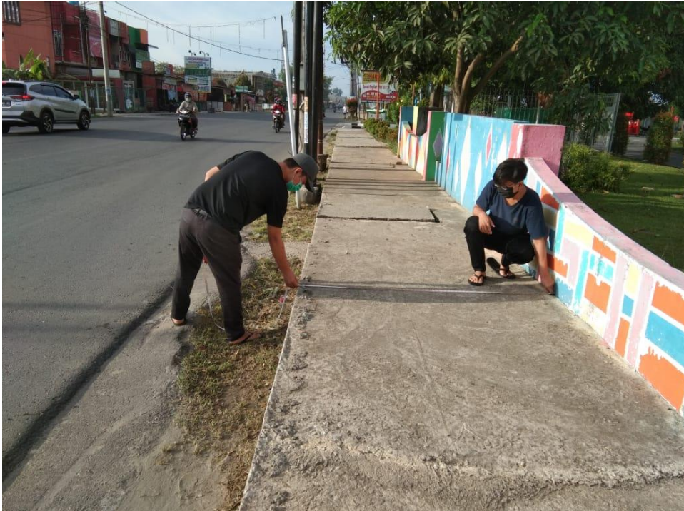
Gambar L.9: Pengukuran bahu jalan dan pedestrian
