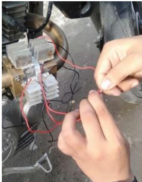
Gambar 3.24 Penyambungan kabel peltier
