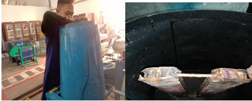
Gambar 4.17. Memasang Honeycomb ke tangki
