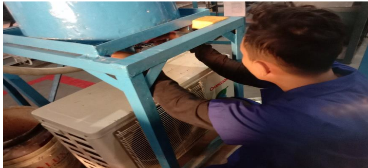
Gambar 4.18. Menyambung Alat Penukar Kalor ke Jalur Refrigerant
