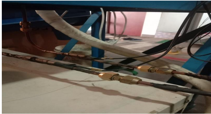
Gambar 4.30. Sensor Suhu Masuk Kondensor
