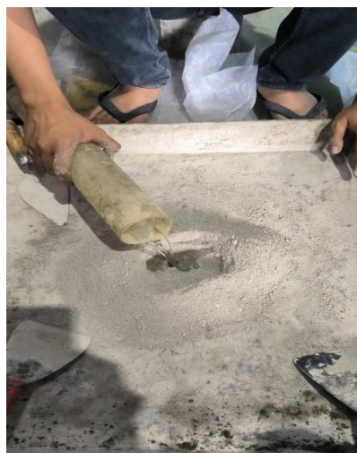
Gambar 3. Pembuatan mortar
