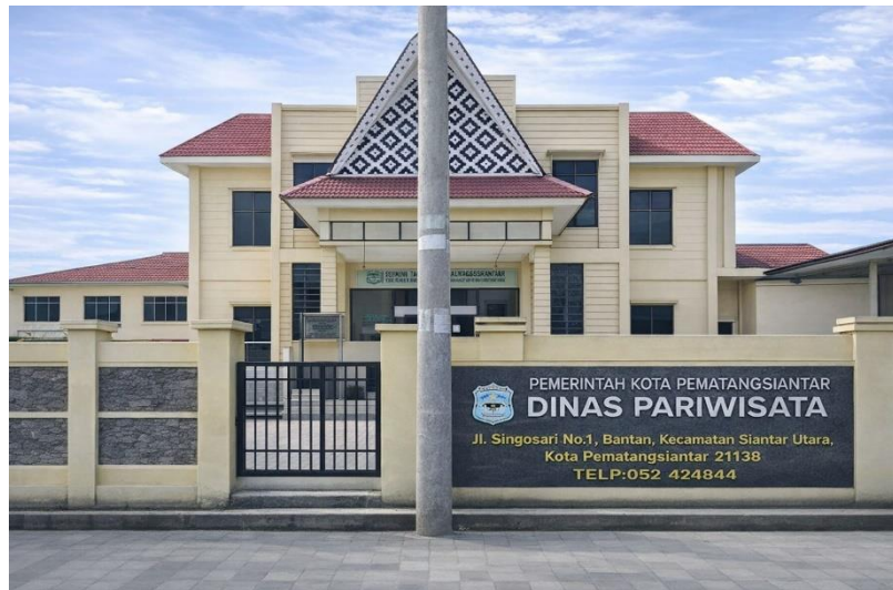
Gambar 4.1 Lokasi Kantor Dinas Kota Pematangsiantar
