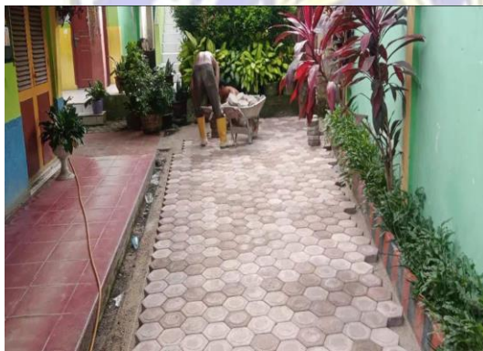
Foto pemasangan Paving Block
