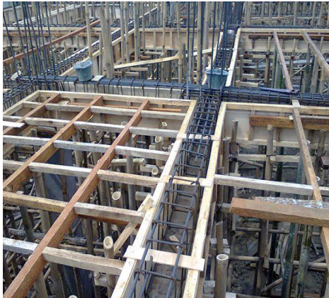
Gambar. 4.7. Sambungan balok dan plat lantai
