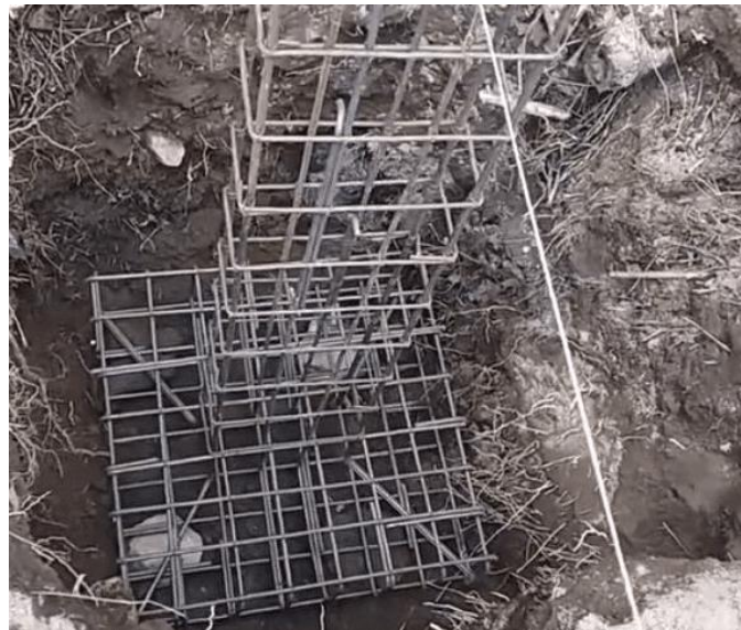
Gambar. 4.2. Kedalaman pondasi tapak
