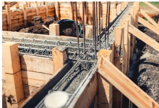
Gambar.4.3. Pemasangan sloof
