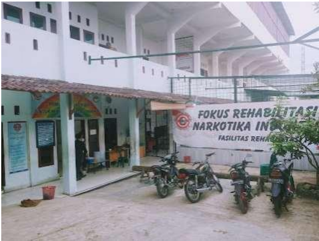
Keterangan : Kondisi Gedung Fokus Rehabilitasi Narkotika Indonesia Marindal 1 Kecamatan Patumbak Deli Serdang
