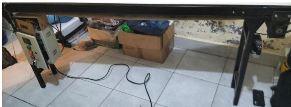
Gambar 2. 19 Tiang Penyangga Conveyor
