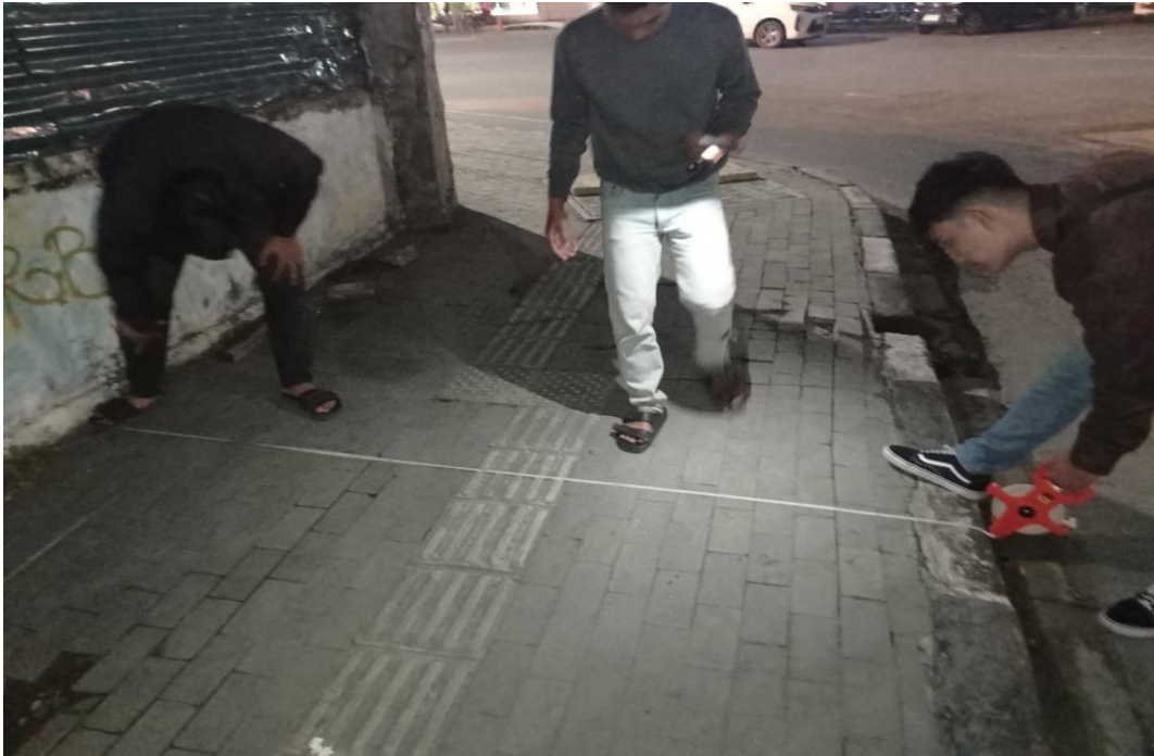
Gambar L.2 proses pengukuran bahu jalan
