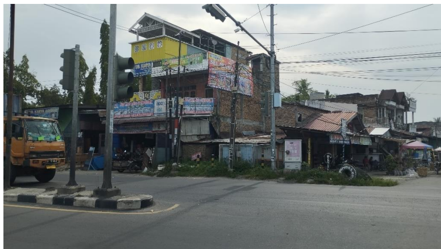
Gambar L.5 Kondisi lengan selatan
