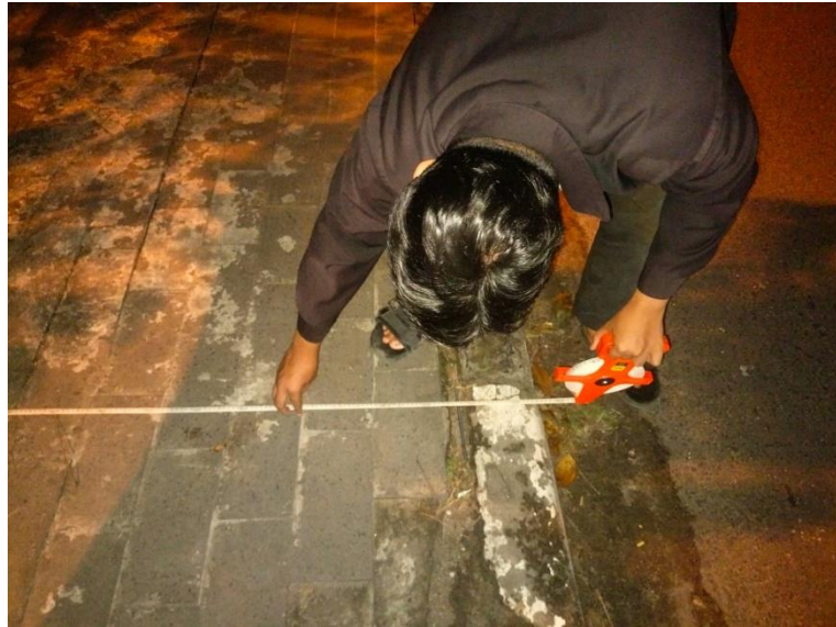
Gambar Pengukuran Bahu Jalan (Survey)
