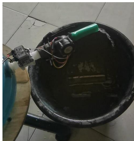
Gambar 4.21 Pengukuran Flow meter pada saluran air
