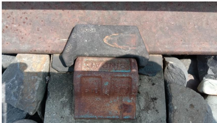
Gambar 10. Sebelum Dipasang Penambat Pandrol
