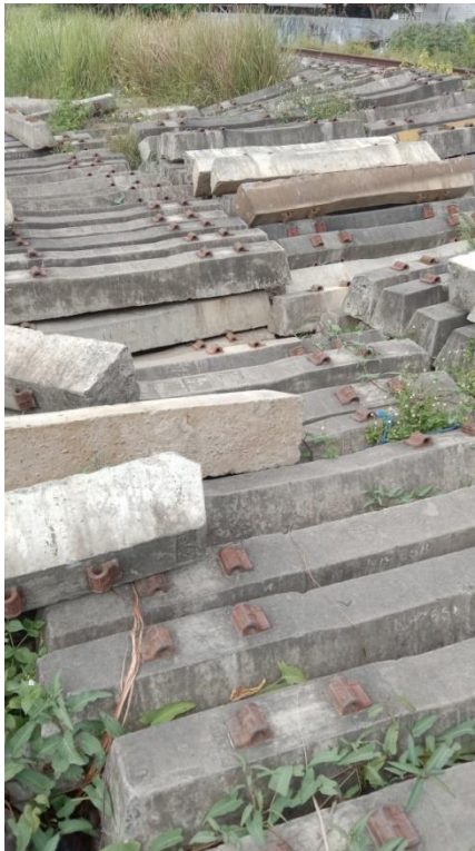
Gambar 8 . Bantalan Beton Sudah Tak Terpakai
