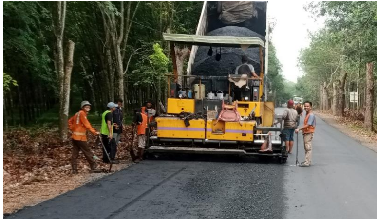
Gambar L5 : Dump Truck menuang aspal ke Asphalt Finisher
