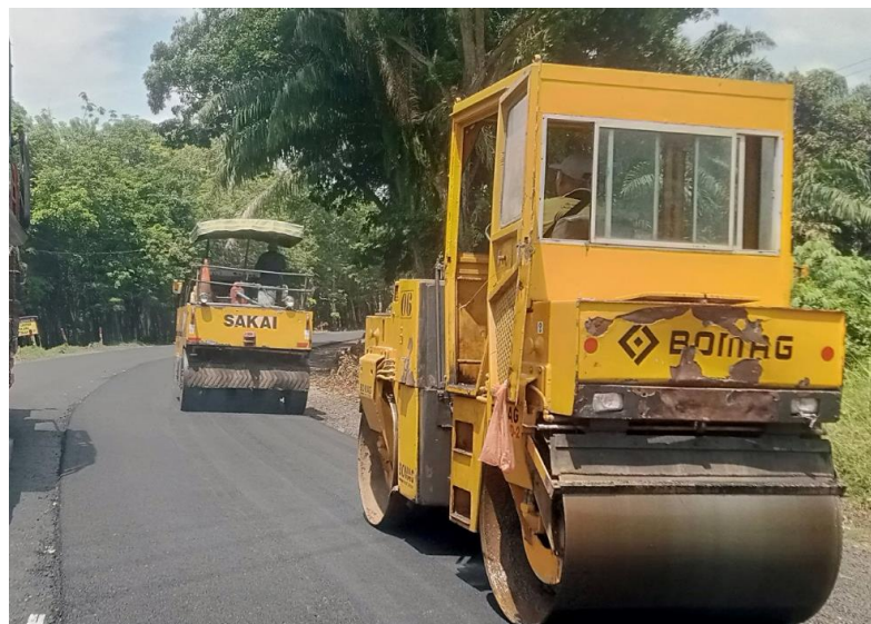
Gambar L6 : Pemasakan Menggunakan Tandem Roller dan Pneumatic Tire Roller
