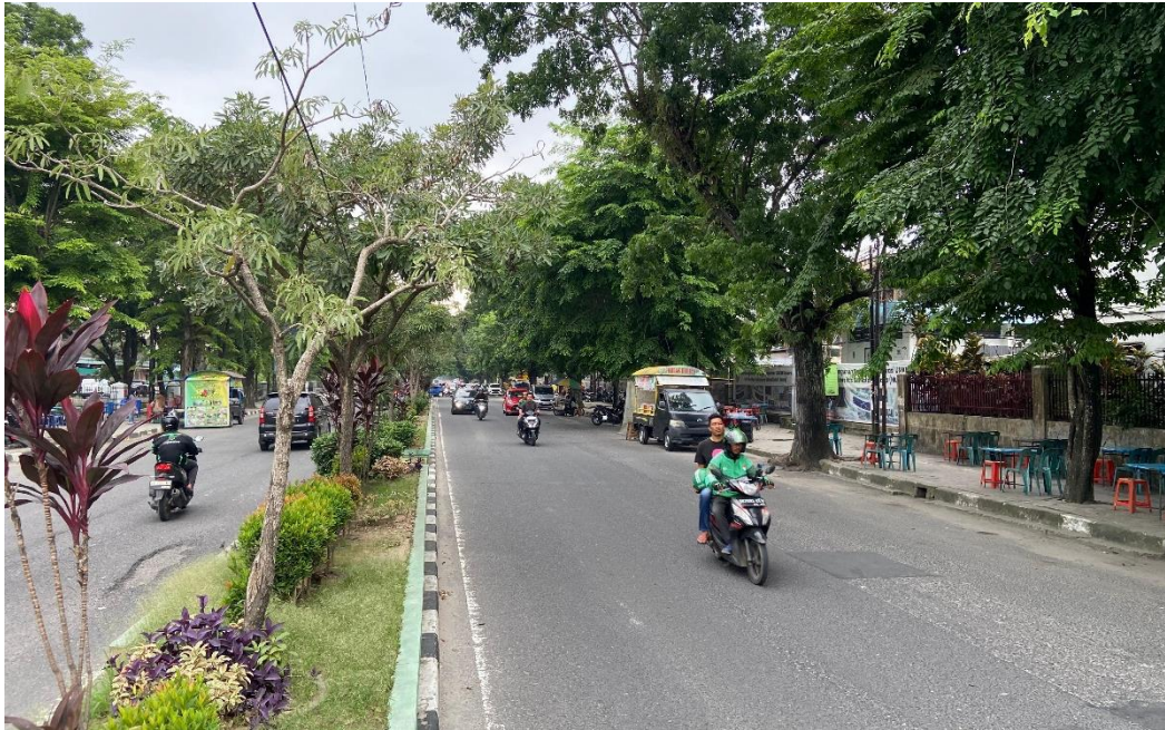
Gambar L. 1.3:Kondisi Fisik Ruas Jalan Dokter Mansyur
