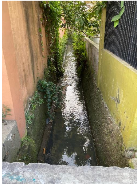
Gambar 4.6: Drainase Eksisting Saluran Primer II
