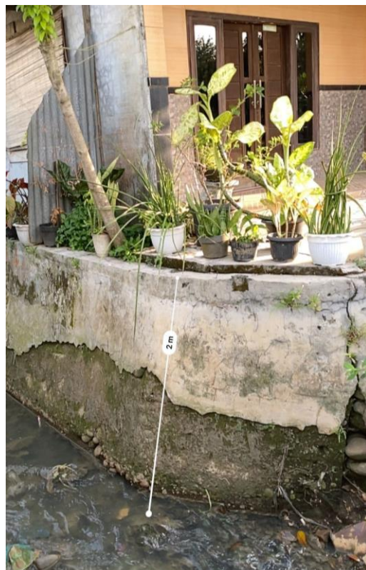
Lampiran A.4 Survei langsung perhitungan penampang saluran drainase menggunakan mobile
