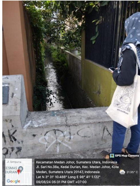
Lampiran A.2 Survei langsung saluran drainase primer II eksisting
