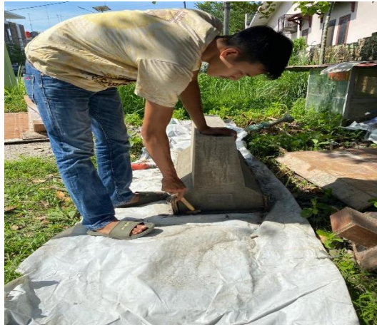
Gambar 4.6 Proses pembukaan cetakan
