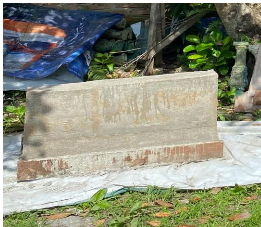
Gambar 4.7 Road barrier dibuka dari cetakan
