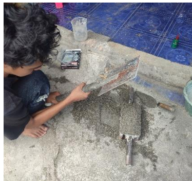
Gambar 4.7 Memadatkan campuran paving di cetakan
