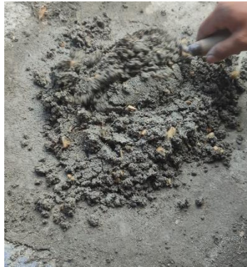
Gambar 4.5 pencampuran semua bahan paving block
