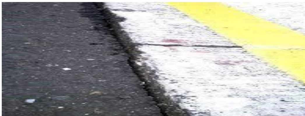
Gambar 2. 7 : Retak Refleksi (dpu.kulonprogokab n.d.)
