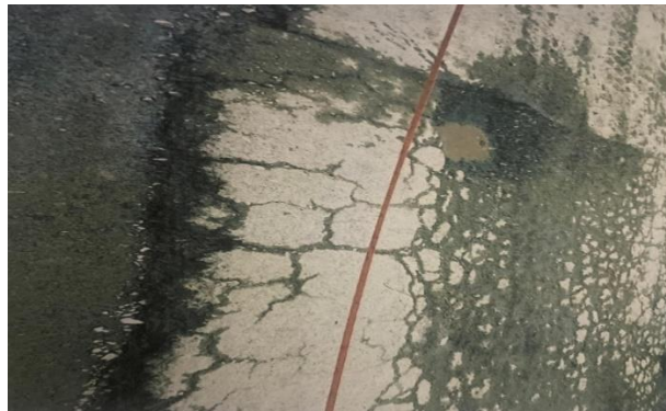
Gambar 3. 4 : R.Kulit Buaya pada Ruas Jalan Perniagaan
