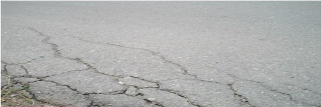
Gambar 2. 4 : Retak Pinggir (Crack Edge) (dpu.kulonprogokab n.d.)
