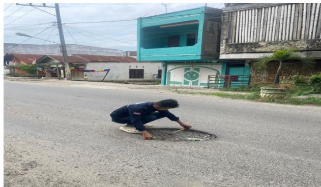
Gambar 3. 5 : Lubang Pada Ruas Jalan Perniagaan
