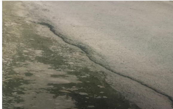
Gambar 3. 6 : Gelombang Pada Ruas Jalan Perniagaan
