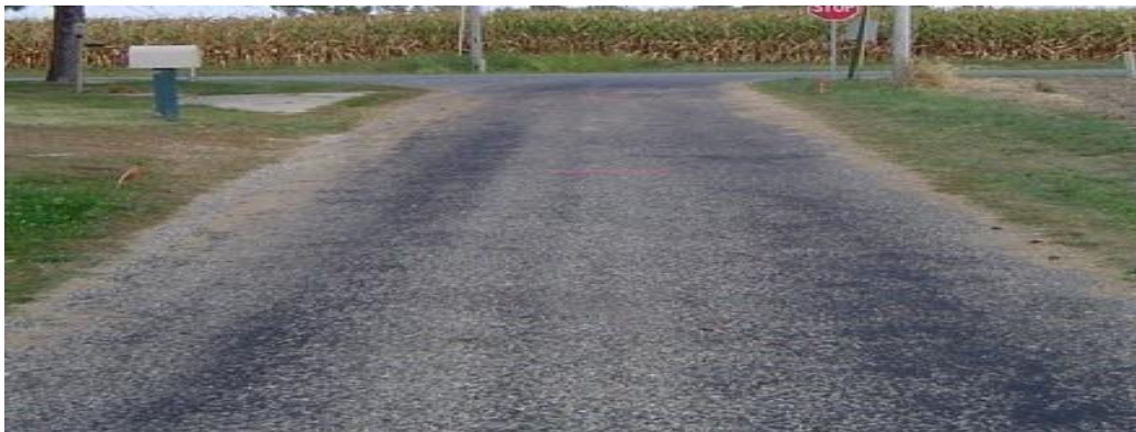
Gambar 2. 19 : Kegemukan (Bleeding / Flushing) (dpu.kulonprogokab n.d.)
