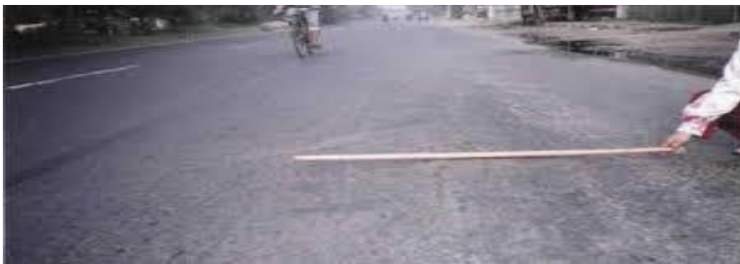
Gambar 2. 14 : Jembul (Upheaval) (dpu.kulonprogokab n.d.)
