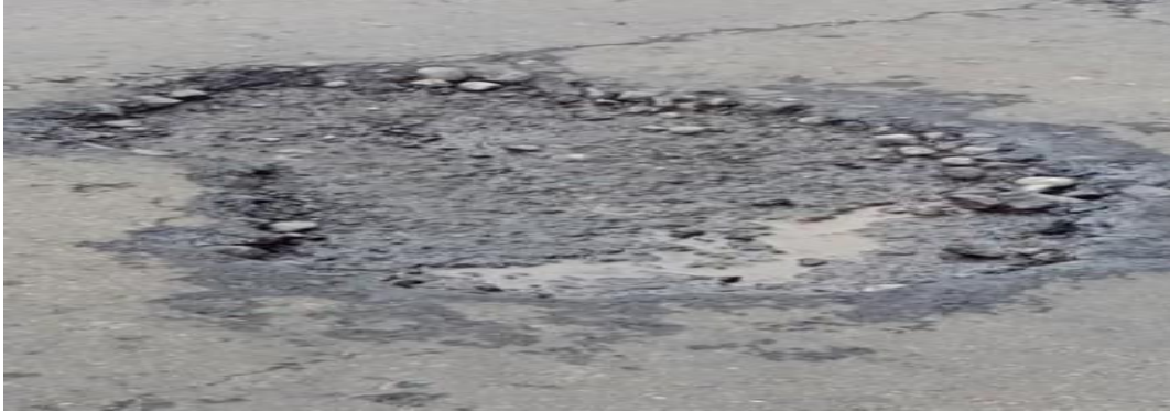
Gambar 2. 16 : Pelepasan Butir (Ravelling) (dpu.kulonprogokab n.d.)
