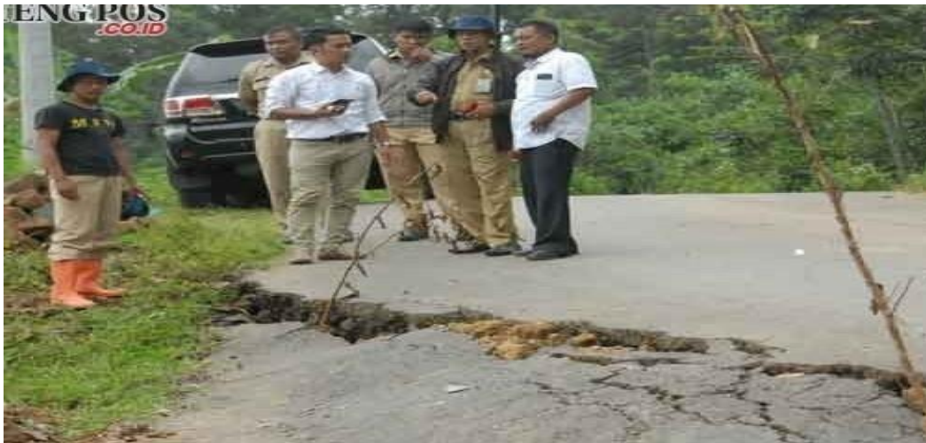
Gambar 2. 13 : Amblas (dpu.kulonprogokab n.d.)
