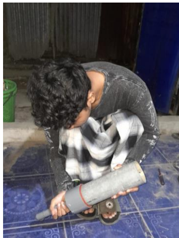
Gambar 4.6 Pemasangan Pipa Pvc Ke Pipa dan Elbow
