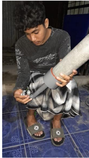
Gambar 4.7 Melakukan Pemasangan Katup Selenoid Valve
