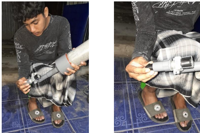
Gambar 4.8 Melakukan Pemasangan Soket dan Nozel ke Selenoid Valve
