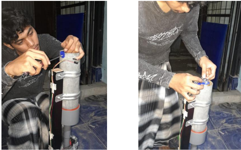
Gambar 4.11 Pemasangan Sensor Ultrasonik
