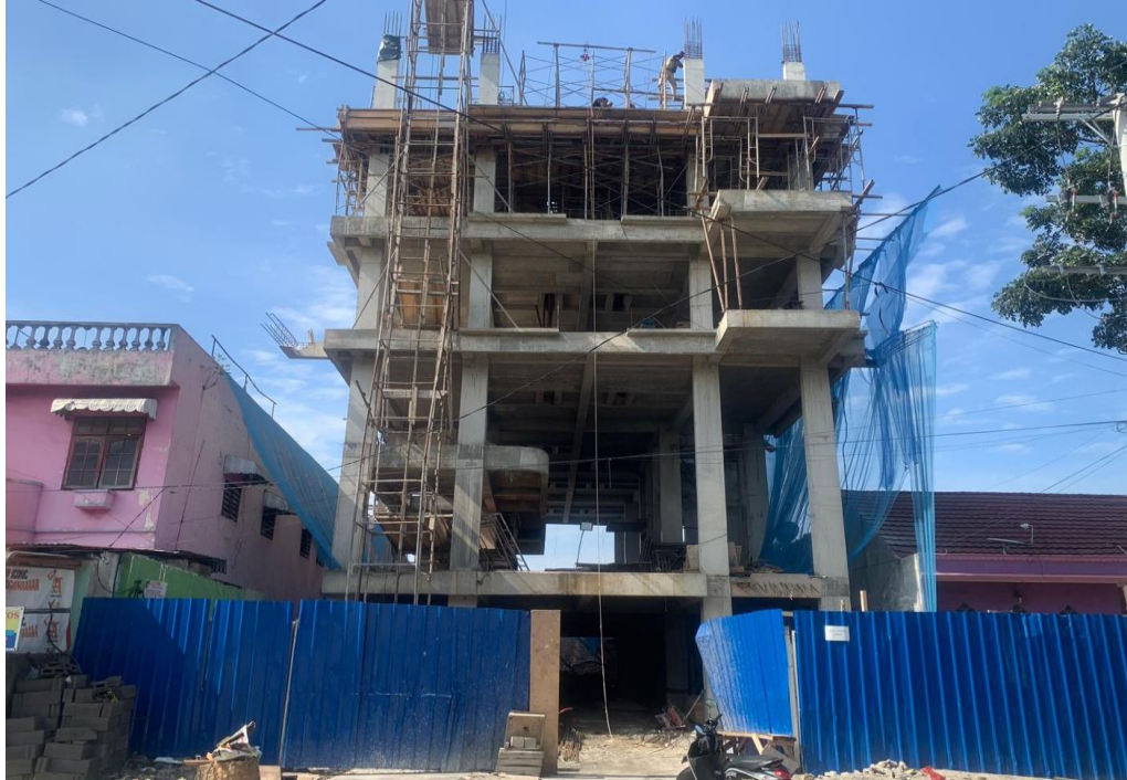
Gambar 3.3 : Kontruksi proyek rumah kost
