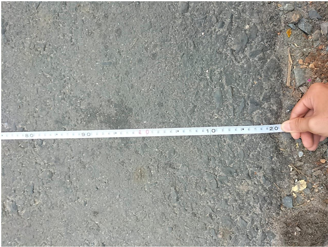
Gambar L.3: Dokumentasi Survei Lapangan
