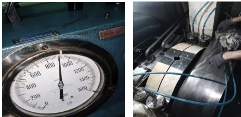
Gambar 4.11 Jack Pump dan Pemasangan tools (PT. Waruna Shipyard Indonesia)
