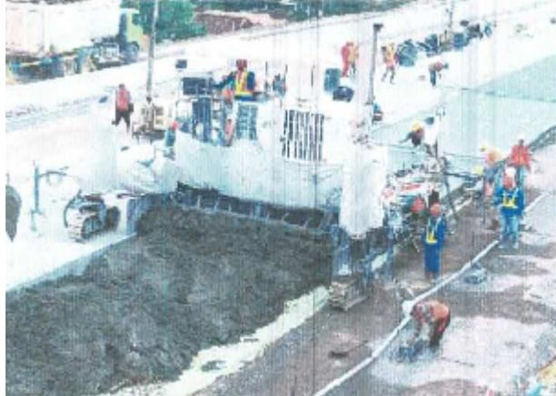
Gambar L1: Penghamparan perkerasan beton dengan concrete paver.
