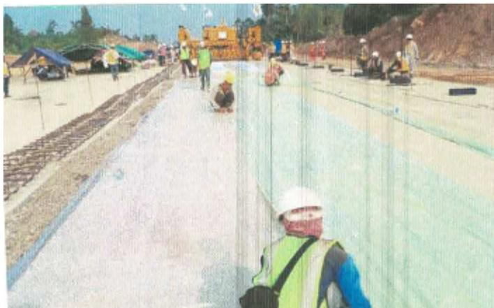
Gambar L3: Pemasangan plastik untuk persiapan pengecoran Lean Concrete.
