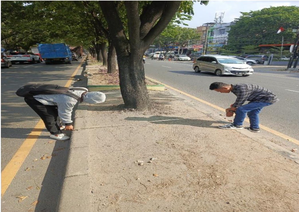
Gambar L.3: Pengukuran lebar Median
