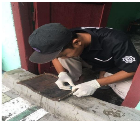
Gambar 3.36 Pemberian Plastisin Pada Cetakan Atap
