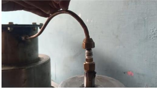
Gambar 4.31 Pemasangan Pipa penghubung
