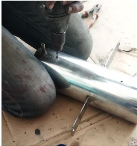
Gambar 4.24 Pengeboran untuk sensor air
