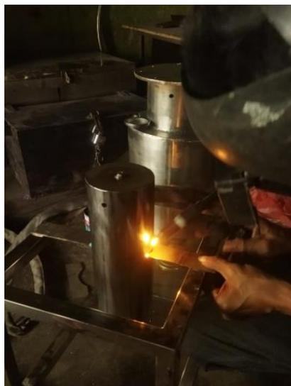
Gambar 4.21 Proses pengelasan dudukan kondensor
