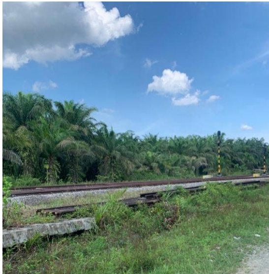
Gambar 12. Rel Dan Bantalan Yang Sudah Tak Terpakai
