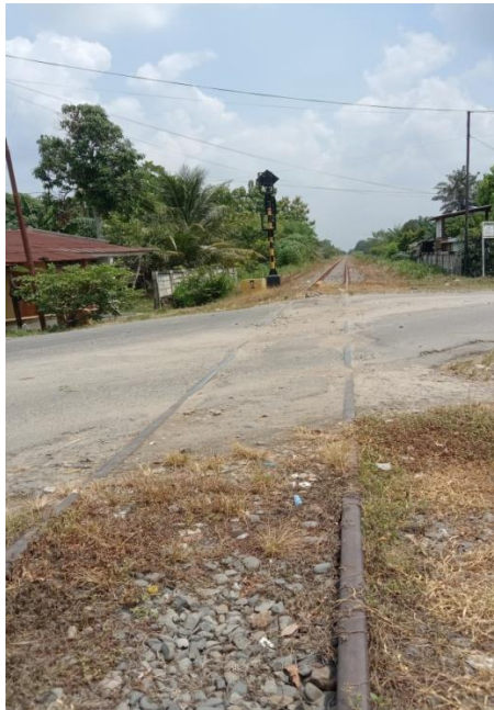
Gambar 6. Jalan Rel Melintasi Jalan Raya
