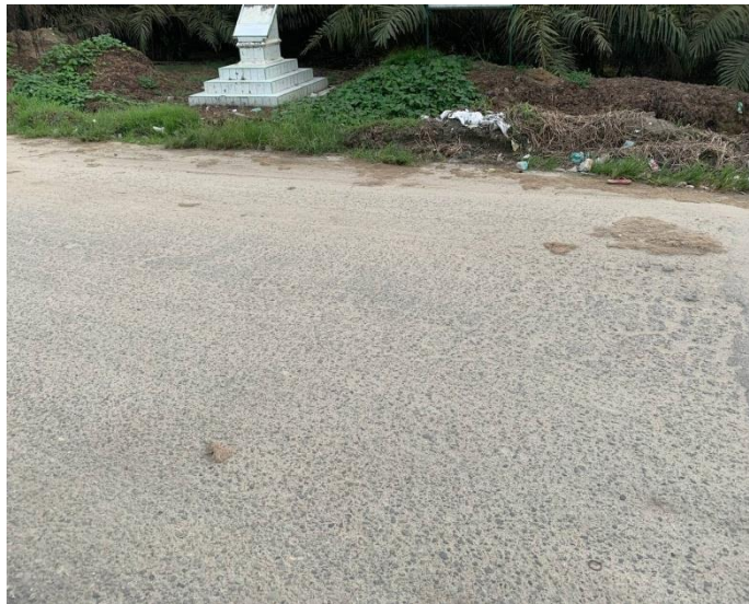
Gambar Lampiran 2 : Pelepasan Butir
