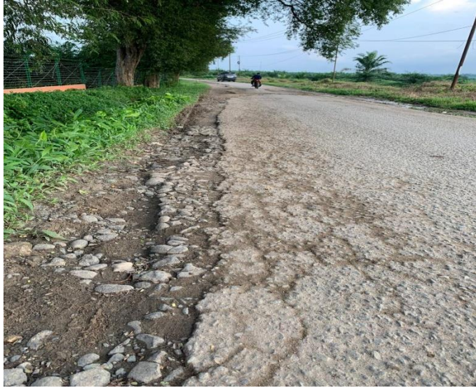
Gambar Lampiran 3 : Retak Pinggir
