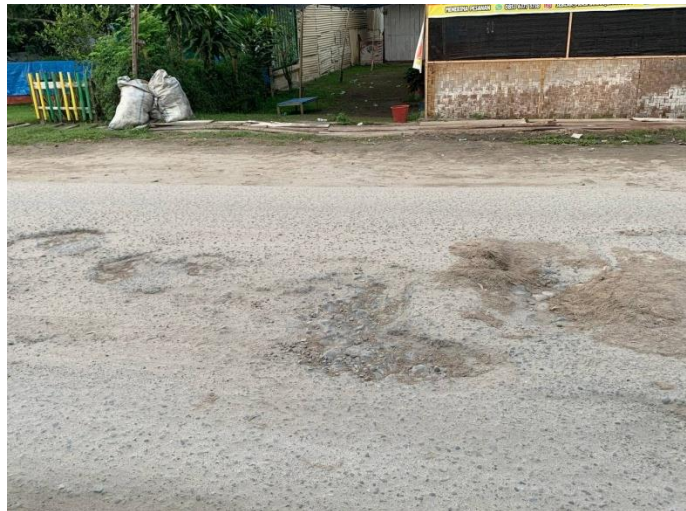
Gambar Lampiran 4 : Lubang
