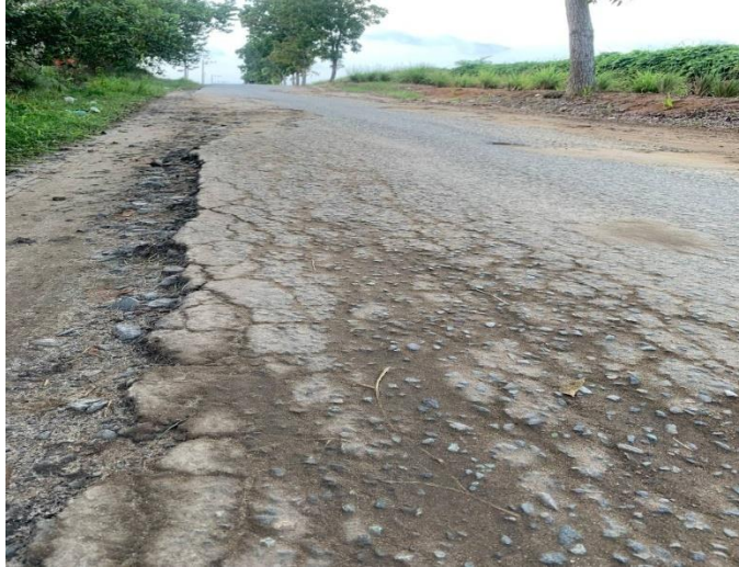
Gambar Lampiran 1 : Retak Kulit Buaya
