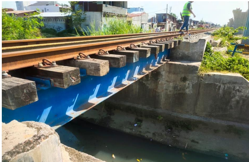
Gambar L.2: Gambar pondasi dan jembatan sei putih.
