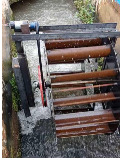
Gambar 4.8 Pemasangan Generator pada saluran irigasi
