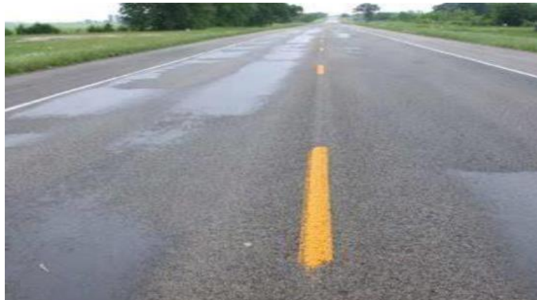
Gambar 2.15 Kegemukan ( Bleeding or Flushing ) Sumber : Dinas PUPR Kulonprogo (2021)
