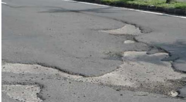
Gambar 2.13. Pengelupasan Lapisan Permukaan
