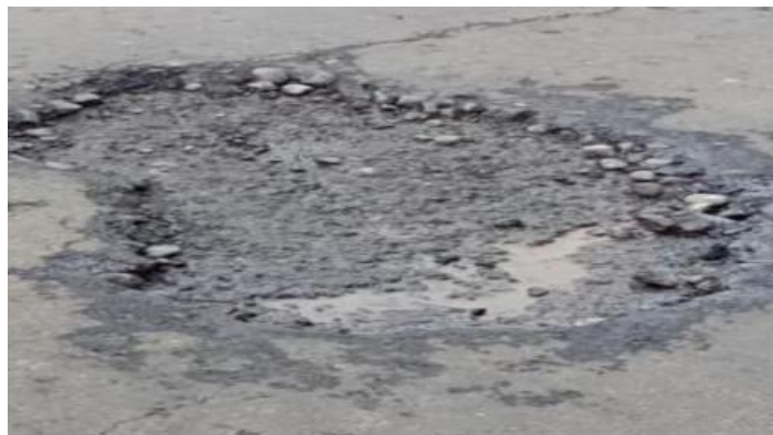
Gambar 2.12. Pelepasan Butir ( Raveling ) Sumber : Dinas PUPR Kulonprogo (2021)
