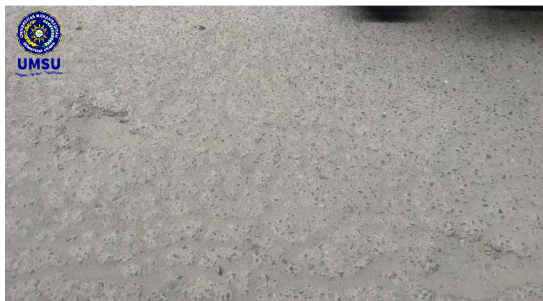
Gambar 4.6 Kekasaran Permukaan ( Rough ) Sumber : Survei Lokasi (2023)
