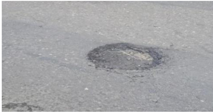
Gambar 2.11. Lubang ( Upheaval ) Sumber : Dinas PUPR Kulonprogo (2021)
