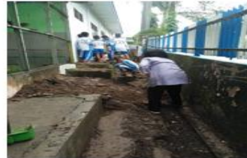
1.2 Memehersihkan selokan/ drainase lingkungan sekolah
