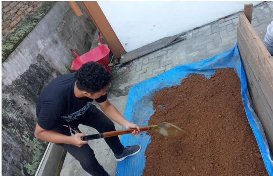
Lampiran 13 Gambar proses pengeringan tanah merah
