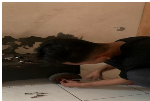
Gambar 4.14 Proses Pemasangan Roda Karet
