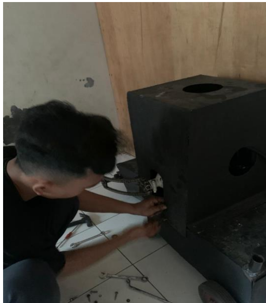
Gambar 4.17 Proses Pemasangan Penutup ( Cover )
