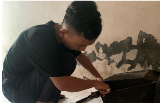
Gambar 4.13 Proses pemasangan penyerok
