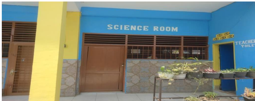
Tampak bangunan ruangan Laboratorium
