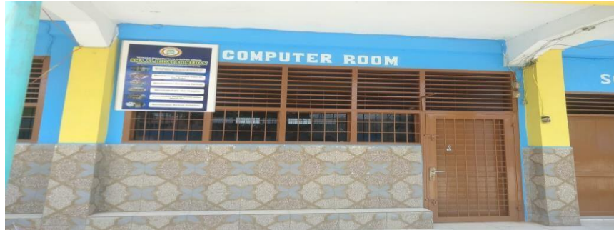
Tampak bangunan ruangan Komputer
