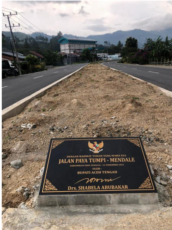
Gambar L1 : Jalan Paya Tumpi - Mendale STA 00+025
