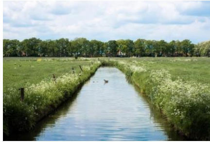
Gambar 2.5 Drainase Saluran Terbuka
