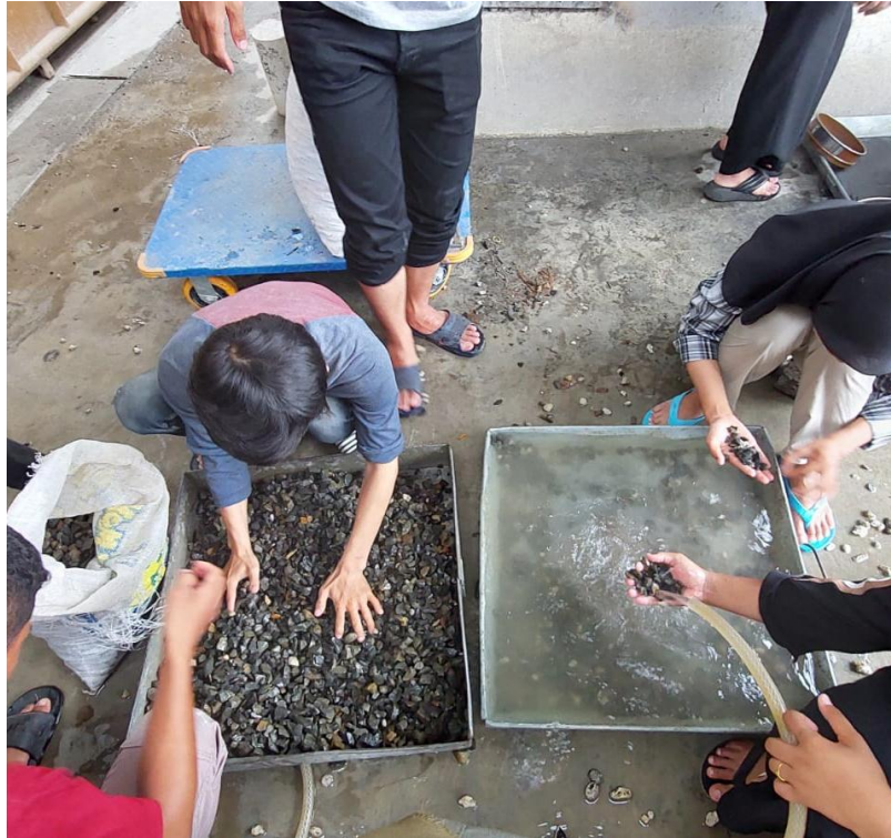
Gambar 7.7: Pencucian agregat dari lumpur dan kotoran
