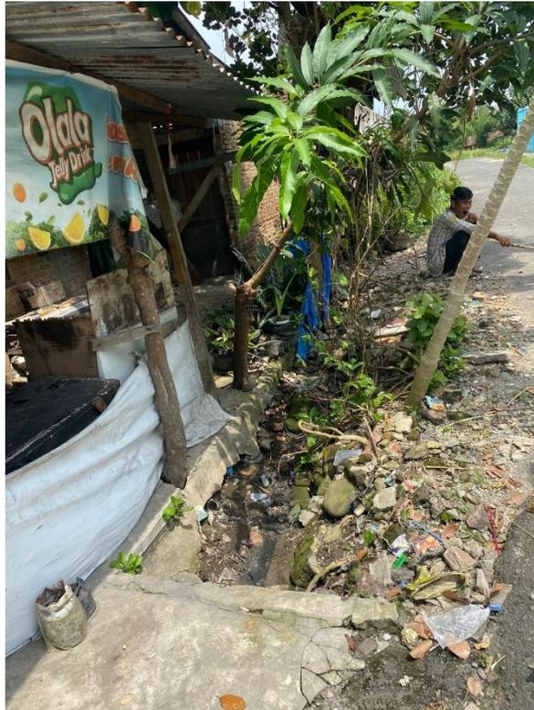
Gambar.L 5. Saluran Drainase Yang Mengalami Kerusakan Sehingga Terganggu Fungsi Drainase Tersebut.
