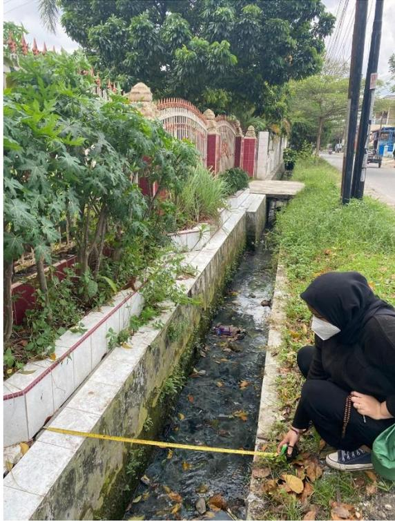
Gambar.L 3. Proses Pengukuran Lebar Drainase.
