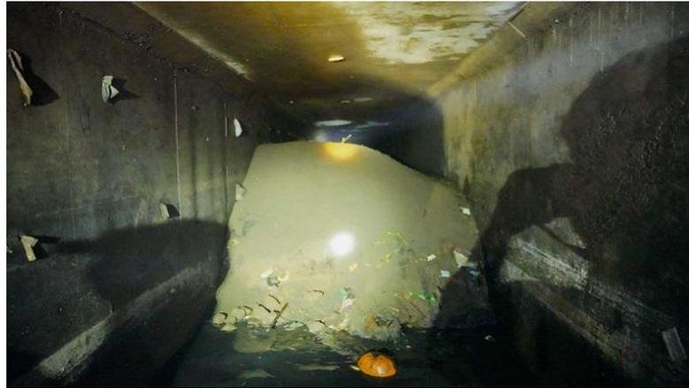
Gambar 2.3: Tumpukan Sedimen Terowongan Drainase MUDP Di Bawah Jembatan Sungai Denai
