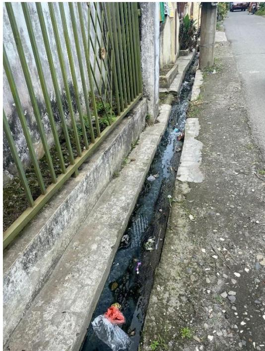
Gambar. L 4. Ukuran Saluran Drainase Yang Sudah Sangat Tidak Layak Fungsi Lagi.
