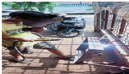
Gambar 4.17 Proses Penyambungan As Baja Dengan Ayakan
