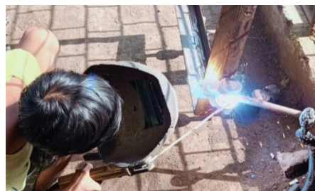
Gambar 4.32 Penyambungan Tuas Penghubung Dengan Ayakan
