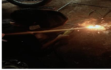
Gambar 4.14 Penyambungan Plat strep
