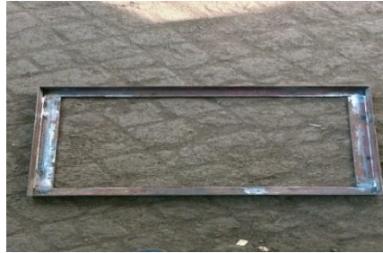
Gambar 4.11 Baja Profil L Setelah Sudah Tersambung
