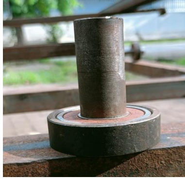
Gambar 4.35 As Sudah Terpasang Dengan rumah Bearing
