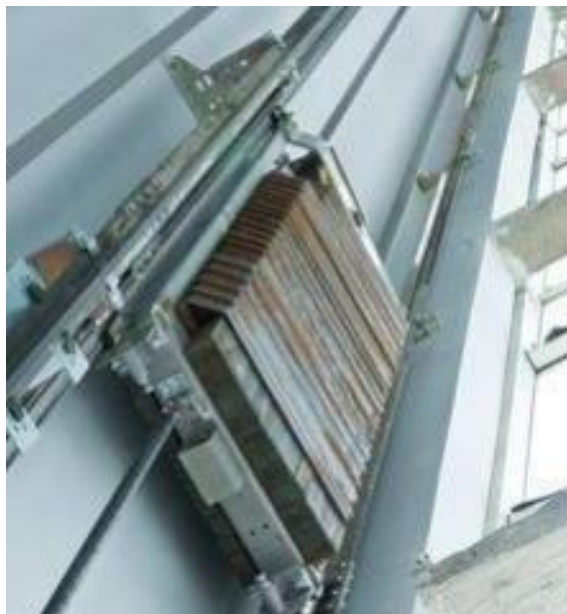
Gambar 2.24 Pengimbang Elevator Sangkar
